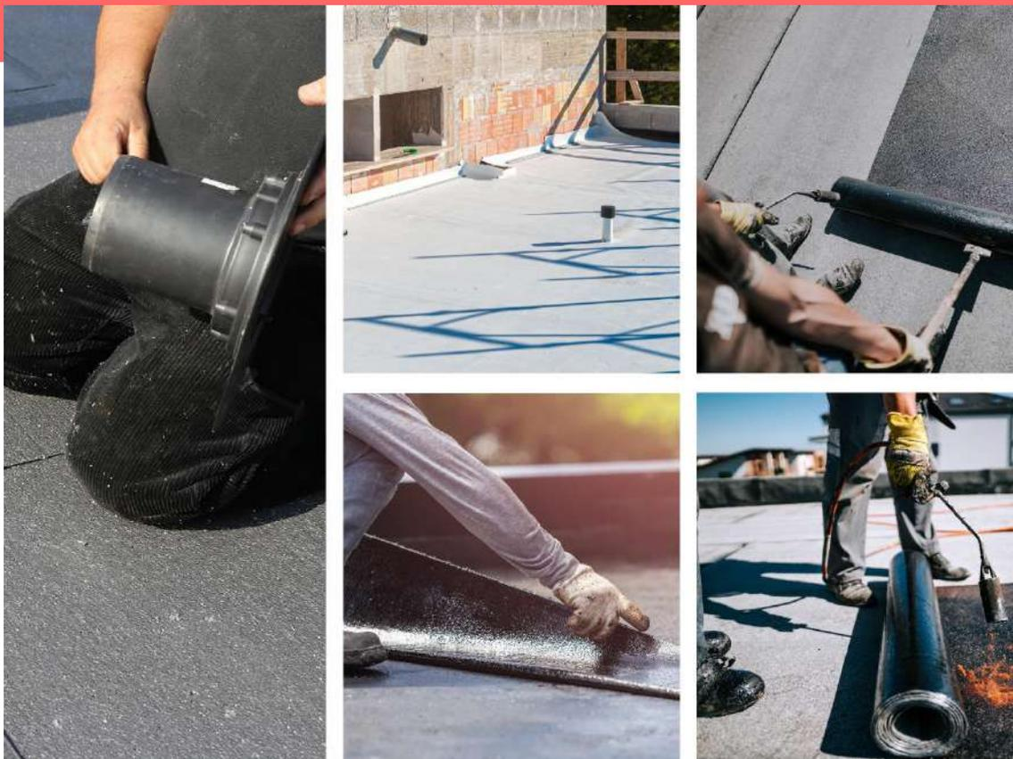
La impermeabilización tiene la función de evitar el paso del agua y la humedad en las cubiertas y otras partes de los edificios o las construcciones. Las láminas impermeabilizantes pueden ser bituminosas o sintéticas.
