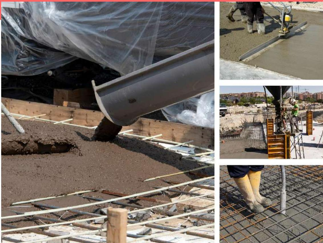
El/la operario/a de hormigón se encarga de la puesta en obra del hormigón, realizando el vertido desde el propio camión hormigonera o desde un cubo de grandes dimensiones (cubilote) que cuelga de una grúa, o dirigiendo la manguera de la bomba que impulsa el hormigón.
